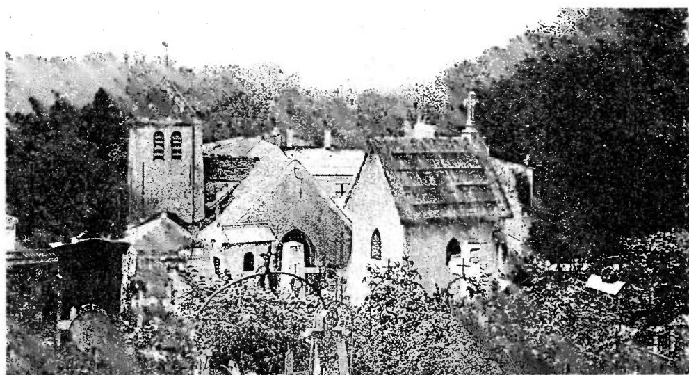
L'ancienne église et l'ancien cimetière
